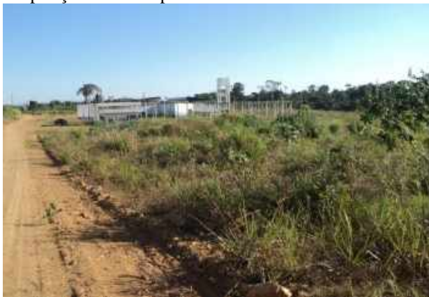
Foto 35: Vista do lixão desativado e em processo de recuperação no Município de Buritis.
