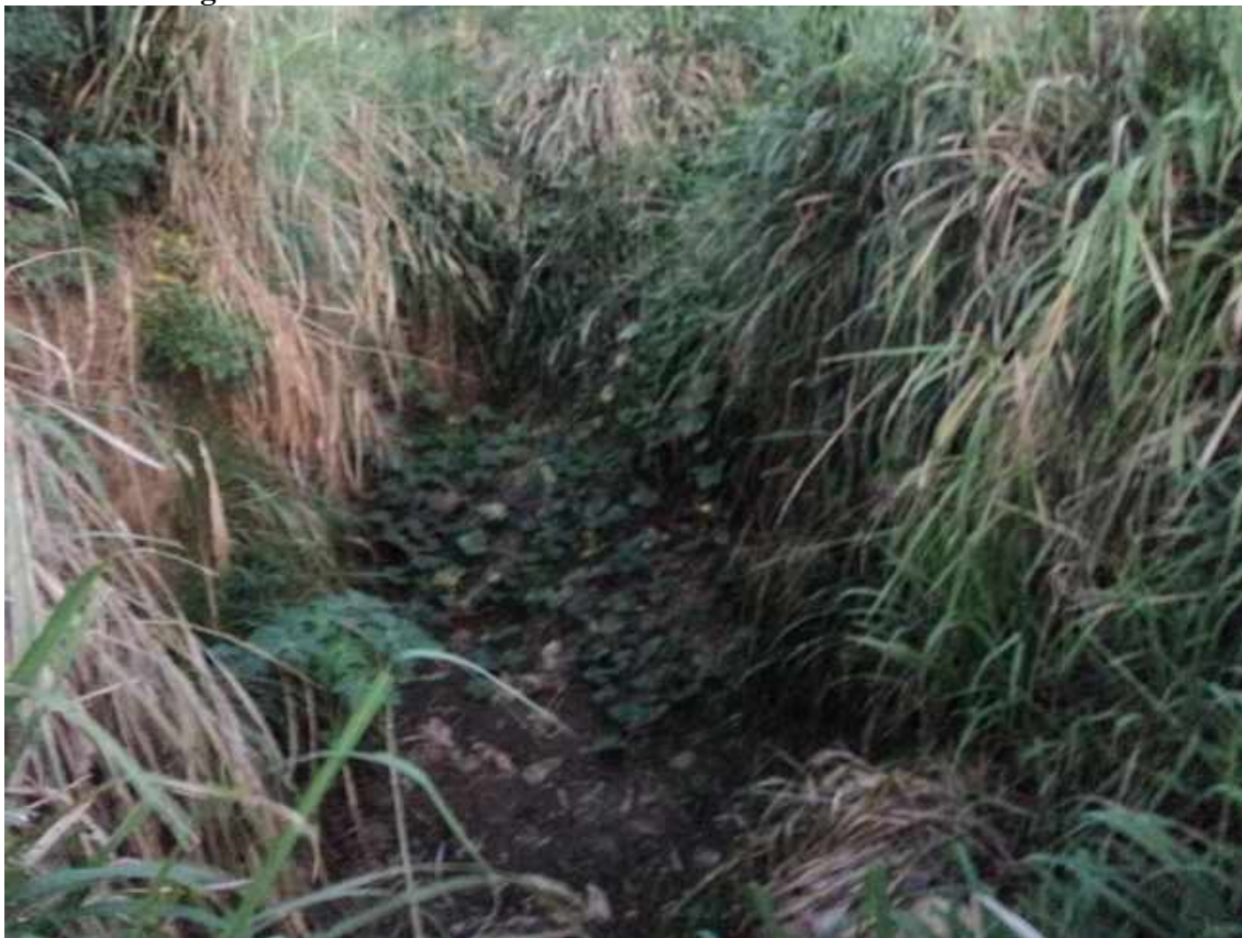
Figura 41 – Detalhe da vala negra onde são depositados os resíduos de natureza líquida oriundos do esgotamento de fossas domiciliares
