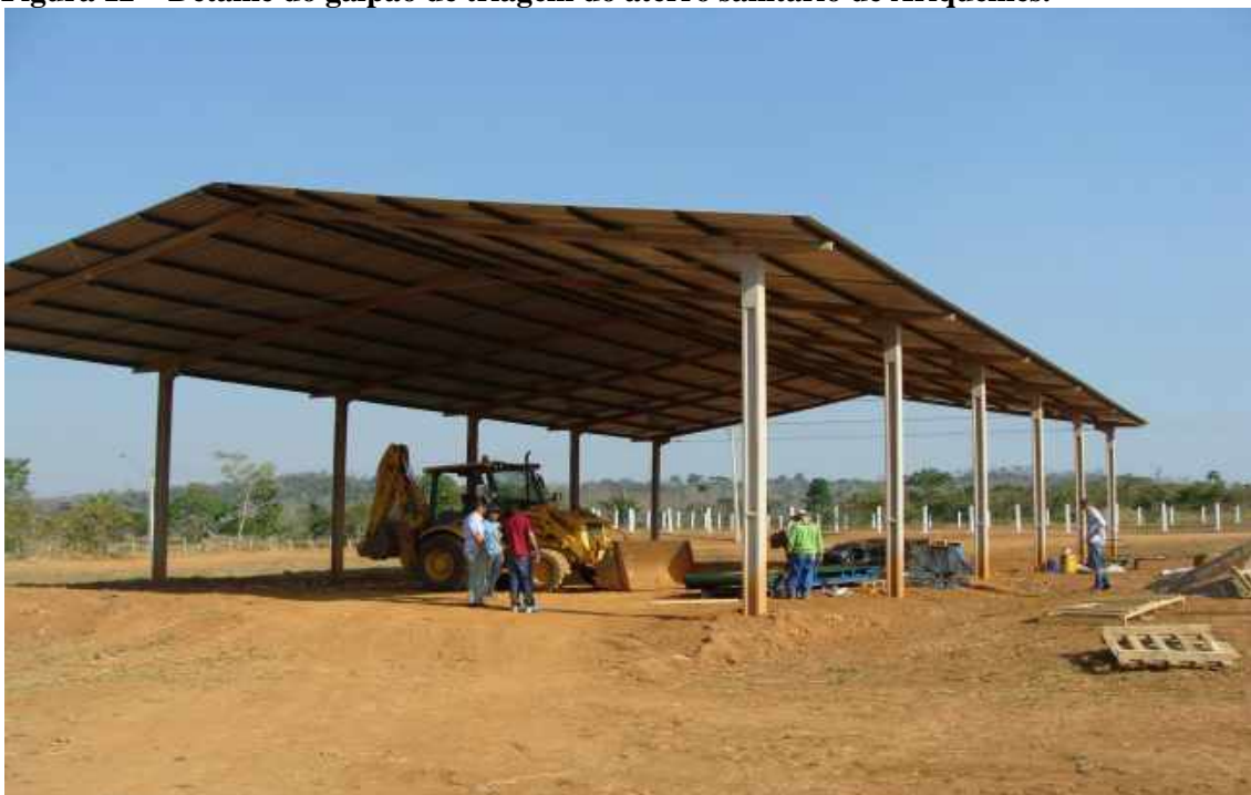
Figura 12 – Detalhe do galpão de triagem do aterro sanitário de Ariquemes.
