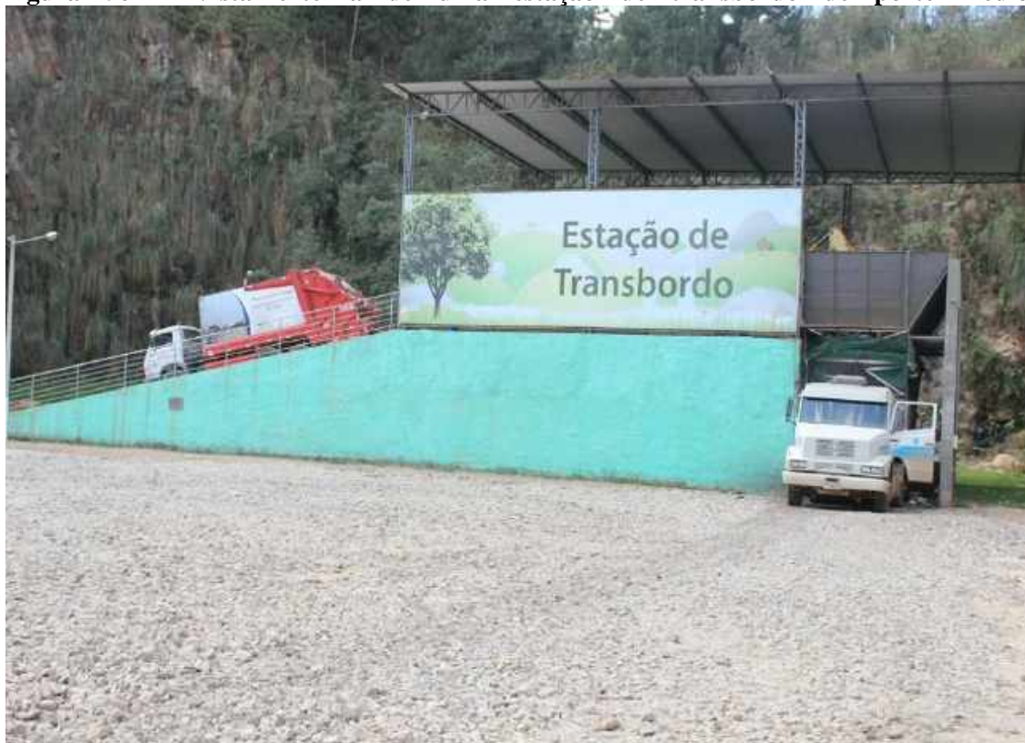
Figura 56 – Vista externa de uma estação de transbordo de porte médio.
