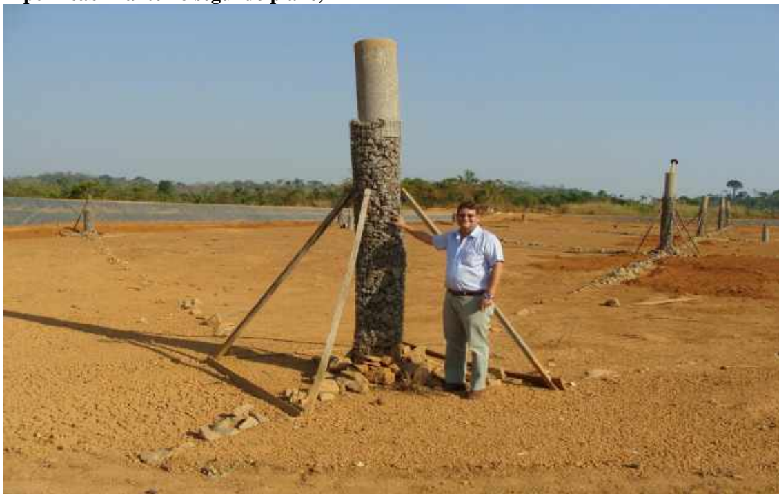
Figura 15 - Detalhe do dreno de gases no primeiro plano e manta bidin (manta impermeabilizante no segundo plano)
