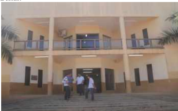
Fotografia 33: Vista da fachada da Prefeitura Municipal de Buritis.
