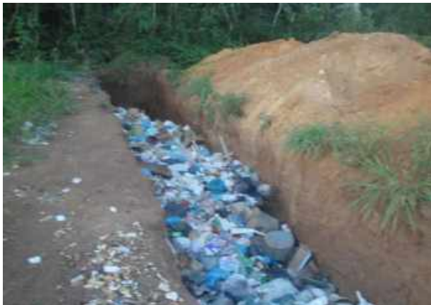
Foto 85: Detalhe das valas escavadas para aterrar os resíduos sólidos no lixão do Distrito de Colina Verde.
