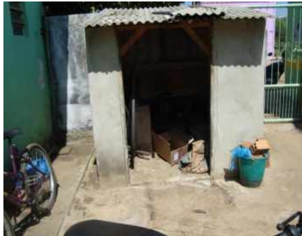
Fotografia 04: Depósito de resíduos de saúde recém construído.
