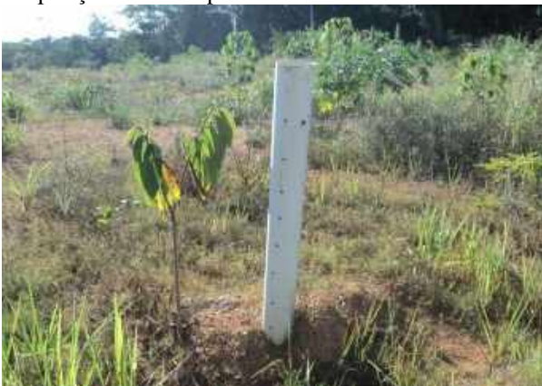
Foto 36: Detalhe do dreno de gás do lixão desativado em recuperação do Município de Buritis.
