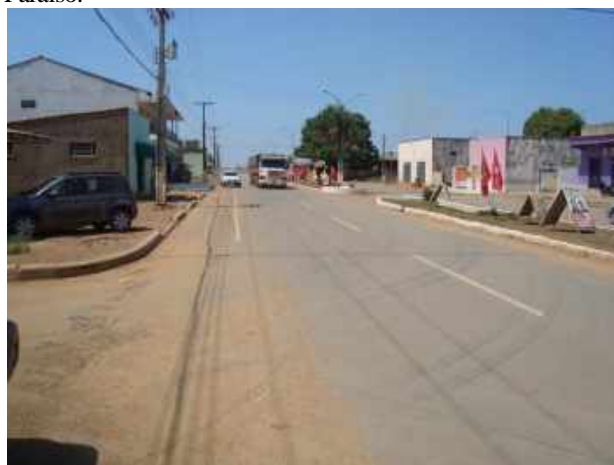
Fotografia 02: Detalhe do arruamento do Município de Alto Paraíso.
