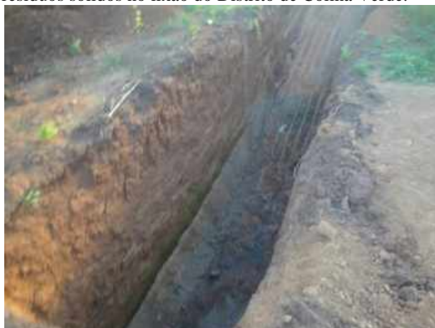
Foto 84: Detalhe das valas escavadas para aterrar os resíduos sólidos no lixão do Distrito de Colina Verde.
