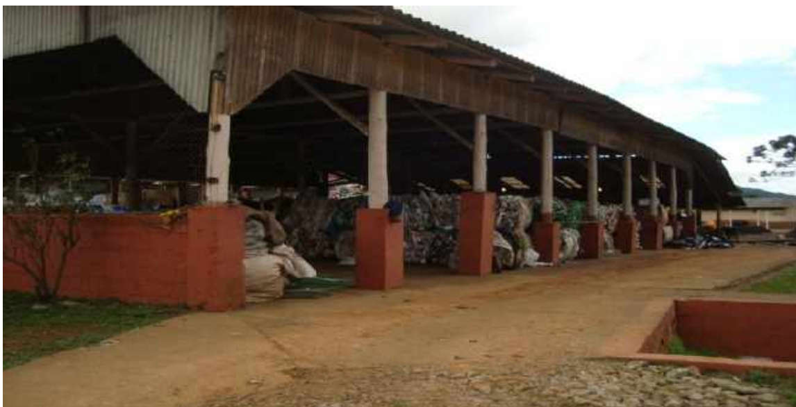
Figura 61 – Vista frontal do Galpão de Triagem de Resíduos Sólidos (Unidade de Triagem e de Compostagem).
