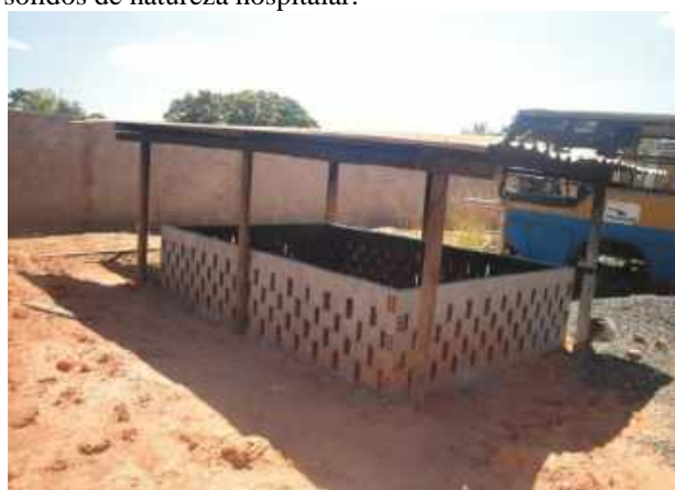
Foto 165: Vista do forno onde são incinerados os resíduos sólidos de natureza hospitalar.
