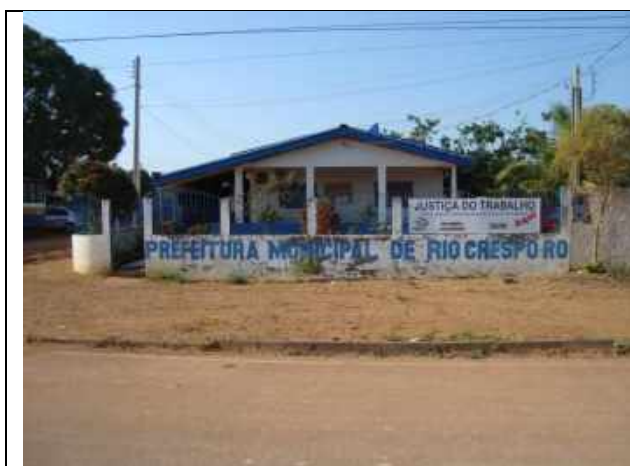
Foto 147: Vista do acesso ao lixão do Município de Rio Crespo.
