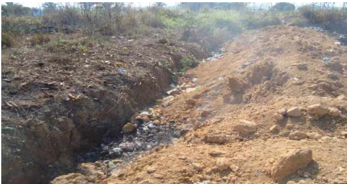
Figura 51 – Detalhe de aterramento da massa de lixo queimada na vala
