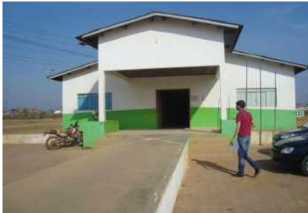
Foto 167: Vista da fachada da Prefeitura Municipal de Vale do Anari.
