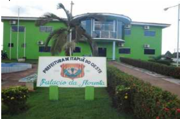
Foto 87: Vista da fachada da Prefeitura Municipal de Itapuã do Oeste.
