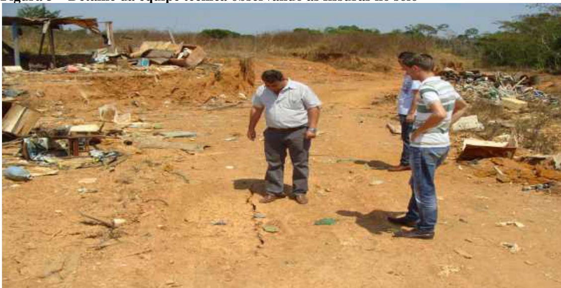
Figura 3 – Detalhe da equipe técnica observando as fissuras no solo
