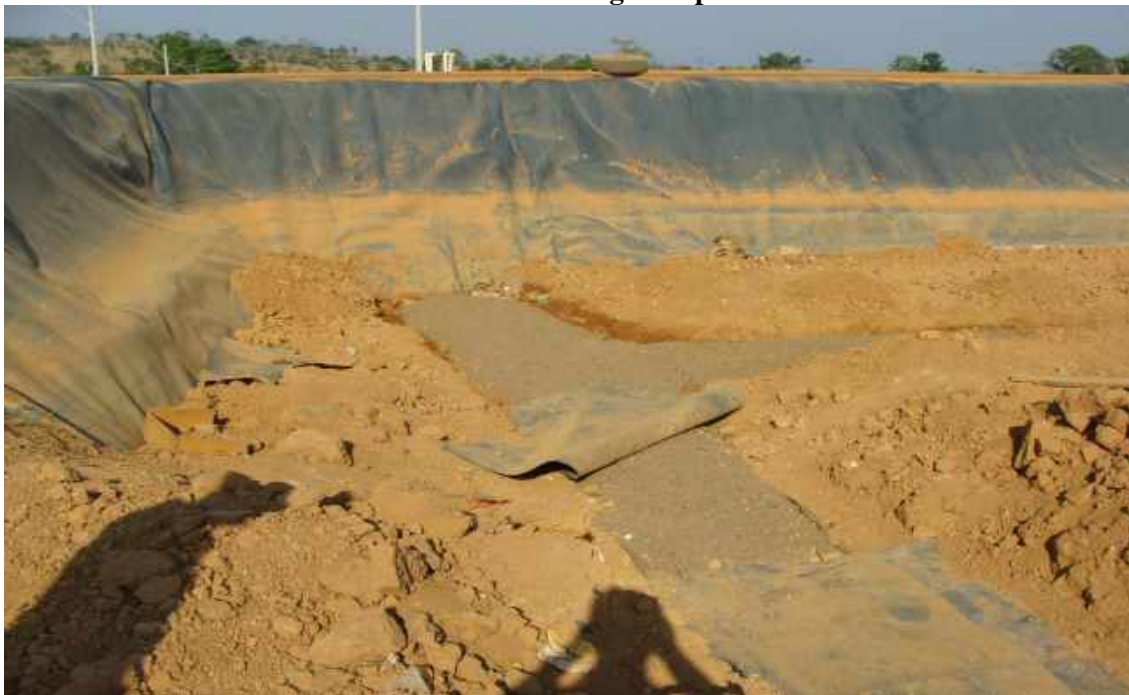
Figura 16 – Detalhe do dreno de percolados na célula receptora no primeiro plano do talude da célula revestido com manta bidin no segundo plano
