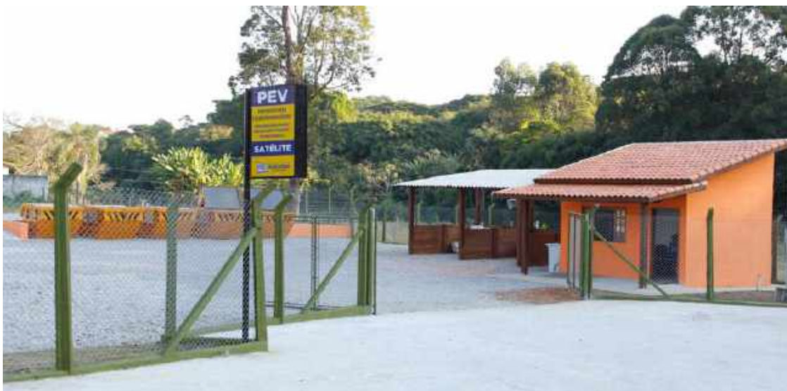
Figura 53 – Vista de uma PEV
