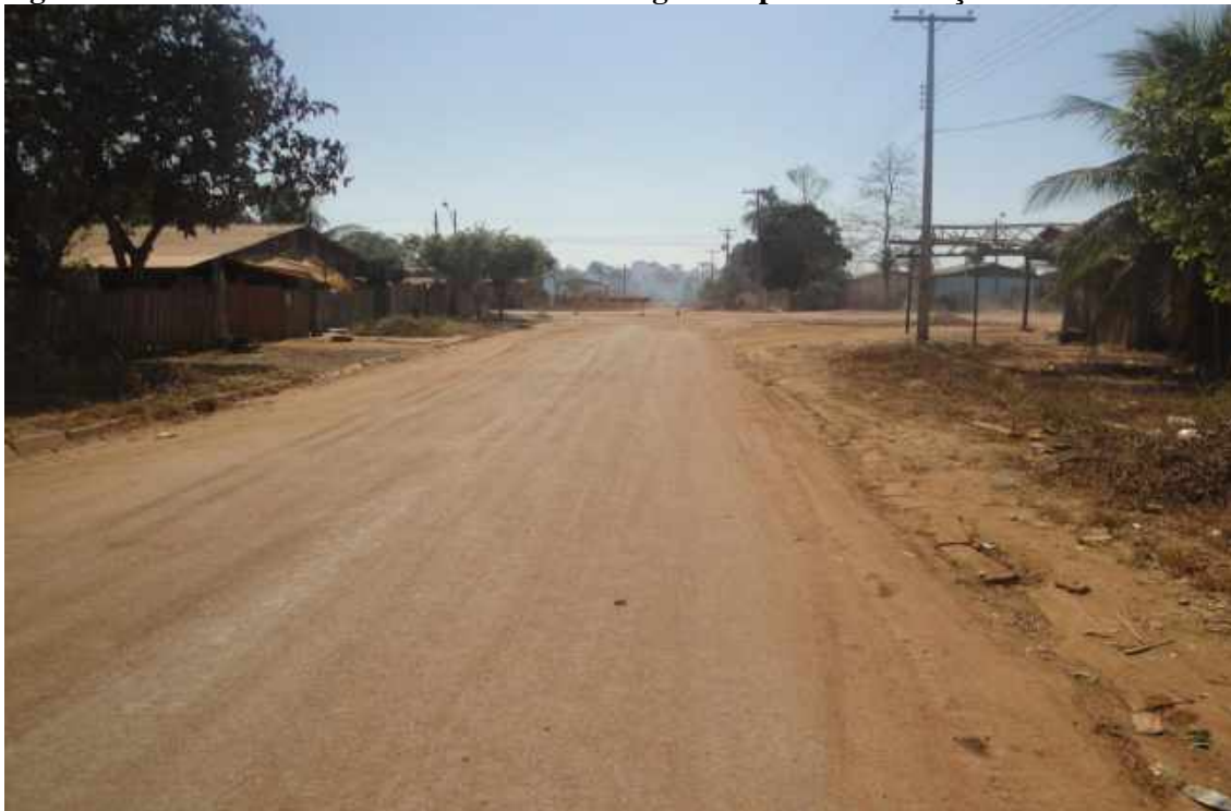
Figura 27 – Vista do arruamento asfaltado e largo e desprovido de calçamento
