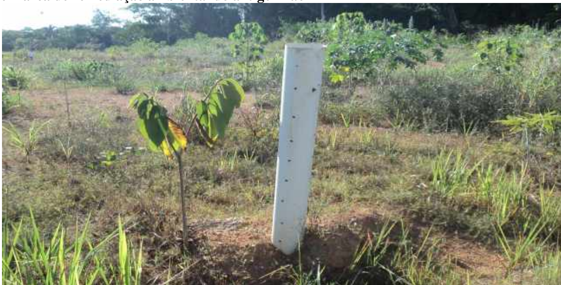
Figura 21– Dreno de gases ao lado de uma planta de Cupuaçu ( Theobroma grandiflorum ), em área de remediação ambiental do antigo lixão
