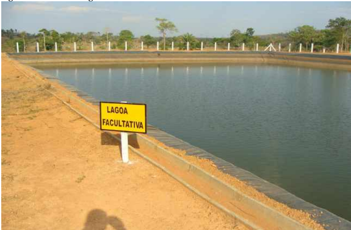
Figura 18 – Vista da lagoa facultativa
